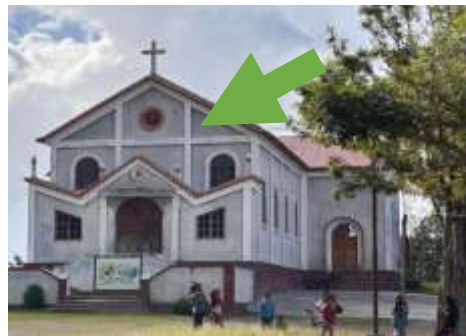
Posizaun solar panel hare husi sul
